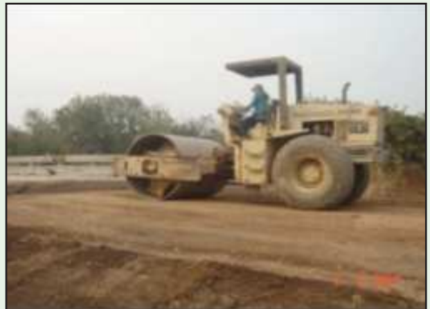
รูปที่ 4-23 การบดอัดบริเวณที่อยู่ใกล้กับโครงสร้าง คสล. ไม่ควรสันสเทือนเนื่องจากจะทำให้โครงสร้างเสียหายได้
