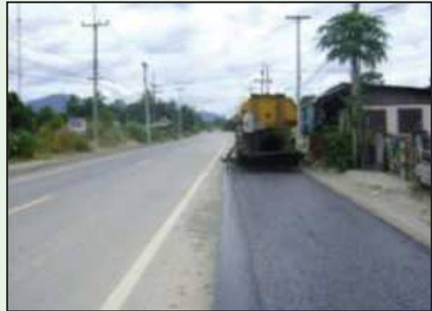
รูปที่ 6-26 การลาดยาง Tack Coat
