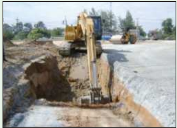
รูปที่ 4-48 การแก้ไขบริเวณชั้นพื้นทางที่เกิดการบวมตัว (Soft Spot)
