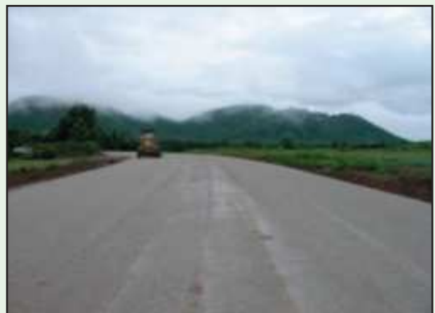
รูปที่ 4-49 พื้นทางที่แล้วเสร็จจะต้องเรียบได้ระดับและความแน่นตามข้อกำหนด
