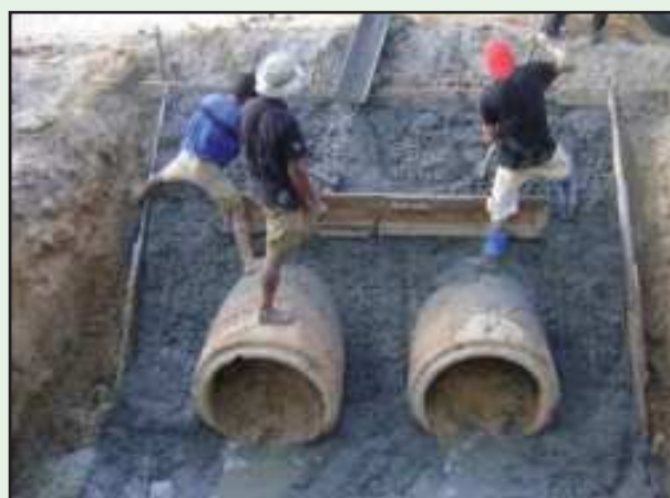
รูปที่ 5-38 การเสริมเหล็ก และการทดสอบกริดกำแพงปากท่อ
