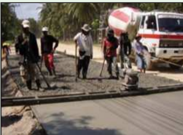
รูปที่ 6-58 ใช้ Front Screen ปาดแต่งผิวคอนกรีตให้ได้ระดับ
