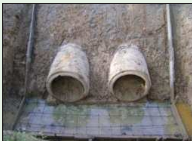
รูปที่ 5-38 การเสริมเหล็ก และการทดสอบกริดกำแพงปากท่อ
