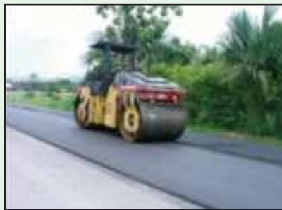
รูปที่ 6-36 การบดทับเริ่มจากบดรอยต่อก่อนและการบดทับด้วยรถบดล้อยาง
