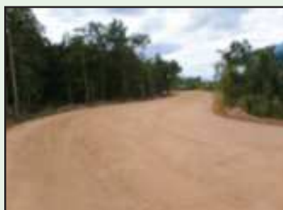
รูปที่ 4-40 ชั้นรองพื้นทางที่เสร็จแล้วเสร็จต้องมีความเรียบและได้ระดับตามแบบแปลน
