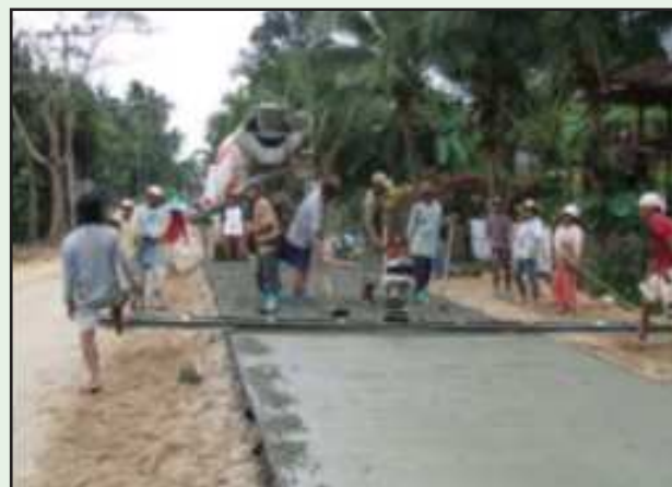
รูปที่ 6-58 ใช้ Front Screen ปาดแต่งผิวคอนกรีตให้ได้ระดับ
