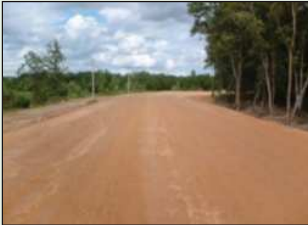
รูปที่ 4-41 ลักษณะของชั้นรองพื้นทางที่แล้วเสร็จต้องเรียบได้ระดับ และความแน่นตามข้อกำหนด
