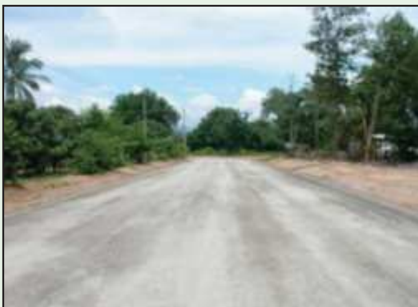
รูปที่ 4-49 พื้นทางที่แล้วเสร็จจะต้องเรียบได้ระดับและความแน่นตามข้อกำหนด
