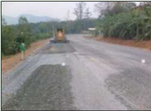
รูปที่ 4-48 การแก้ไขบริเวณชั้นพื้นทางที่เกิดการบวมตัว (Soft Spot)
