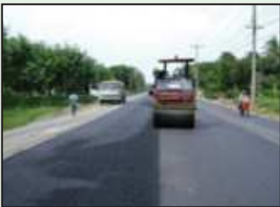
รูปที่ 6-36 การบดทับเริ่มจากบดรอยต่อก่อนและการบดทับด้วยรถบดล้อยาง
