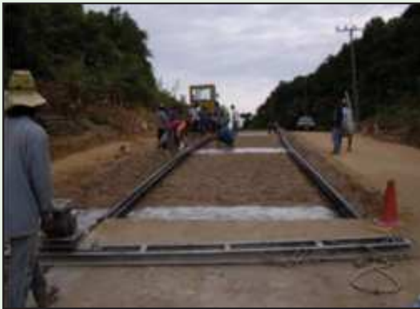
รูปที่ 6-54 ทุรอยต่อต้องวางแผ่นรองกันชื้น
