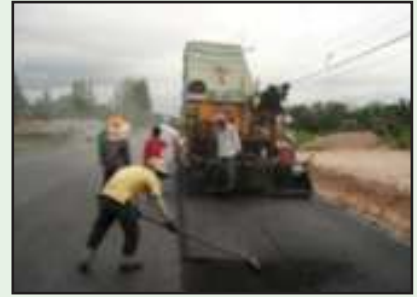
ควบคุมแนวการปู
