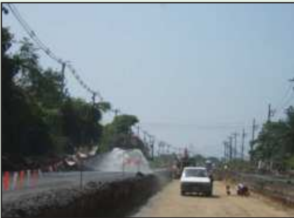
รูปที่ 8-10 การฉีดพ่นน้ำลงบนพื้นที่ก่อสร้างเพื่อลดผลกระทบจากฝุ่นละออง
