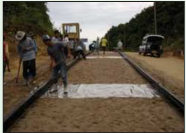
รูปที่ 6-54 ทุรอยต่อต้องวางแผ่นรองกันชื้น
