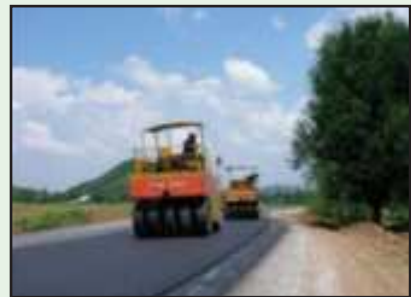
รูปที่ 6-36 การบดทับเริ่มจากบดรอยต่อก่อนและการบดทับด้วยรถบดล้อยาง
