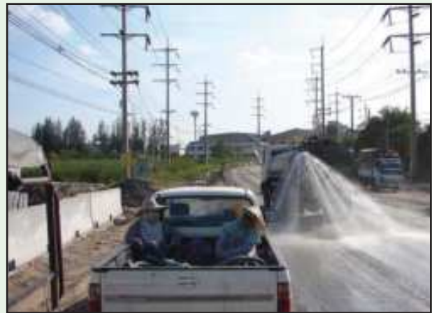
รูปที่ 8-10 การฉีดพ่นน้ำลงบนพื้นที่ก่อสร้างเพื่อลดผลกระทบจากฝุ่นละออง
