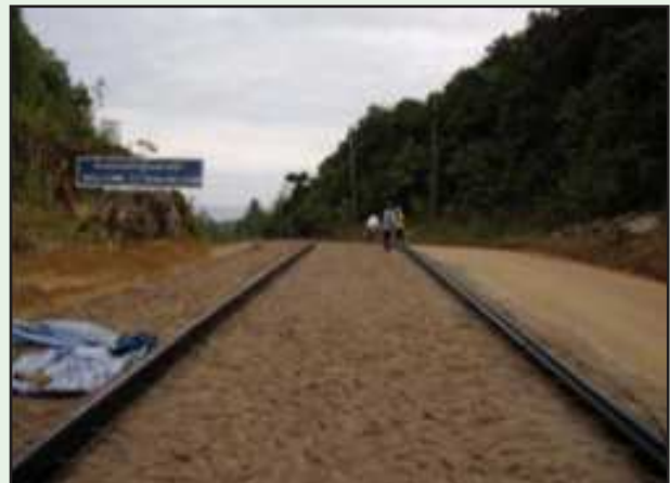
รูปที่ 6-51 การเตรียมชั้นพื้นทางให้พร้อมและตั้งแบบหล่อให้ตรงได้ระดับ
