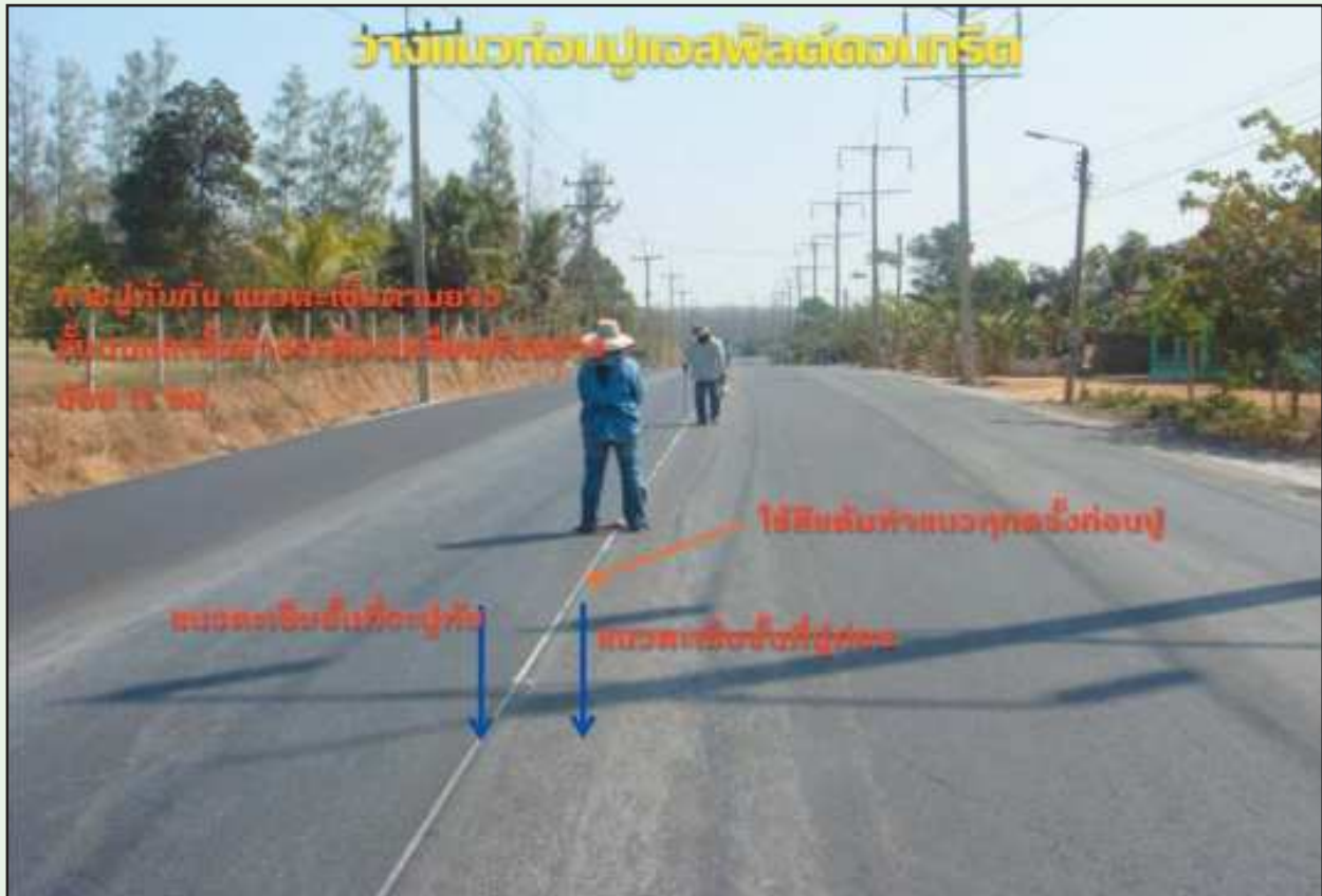
รูปที่ 6-29 แสดงการวางแผนเกลี่ยปูแอสฟัลต์คอนกรีตชั้นถัดไป
