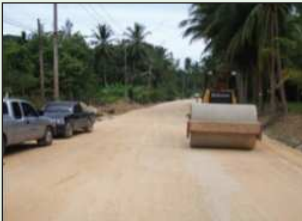
รูปที่ 6-51 การเตรียมชั้นพื้นทางให้พร้อมและตั้งแบบหล่อให้ตรงได้ระดับ
